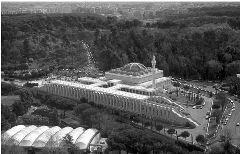
32. Соборная мечеть и исламский культурный центр. Рим. Италия. 1984. Архитектор П. Портогезе. Вид на комплекс
