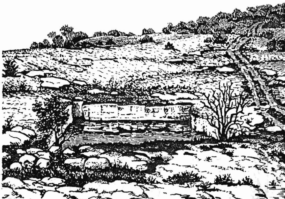
36. Большой водосборный бассейн
