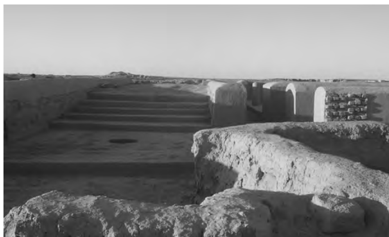
Рис. 5. Лестница и близлежащие помещения дворца Северного Гонура после консервации стен, 2008 г.
