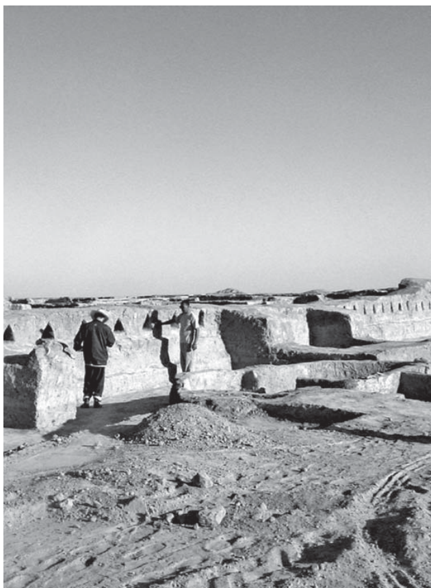
Рис. 2. Восточный фас оборонительной стены гонурского кремля с амбразурами.
