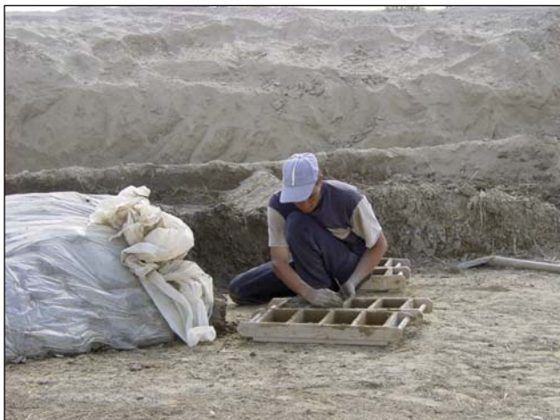
Рис. 9. Одна из стадий изготовления сырцовых кирпичей (заполнение современной специальной деревянной формы глиняным тестом) для консервации стен Гонур-депе. Сентябрь 2009 г.
