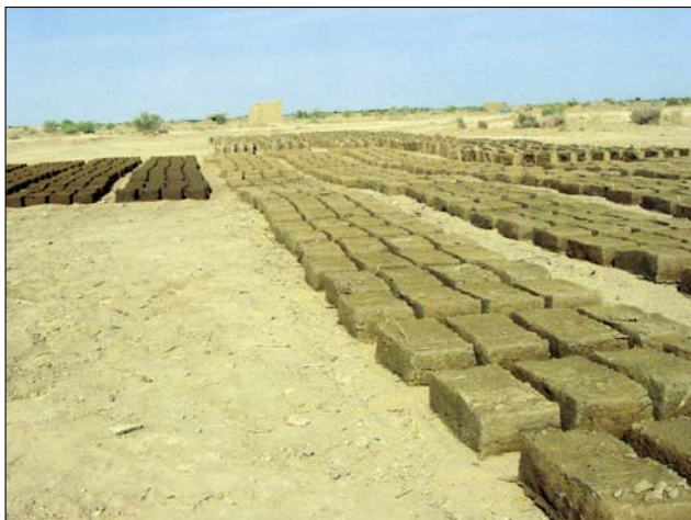
Рис. 10. Сушка современных малоразмерных кирпичей на солнце в процессе консервации стен Гонур-депе. Сентябрь 2009 г.
