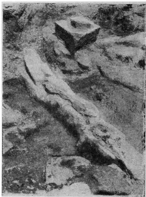
Рис. 5. Северная магистраль водопроводного канала.
