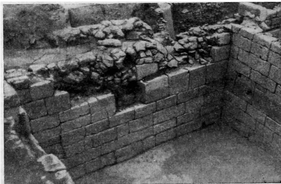
Рис. 7. Участок АГД. Южная часть большого подвального помещения богатого дома V—IV вв. до н. э.
