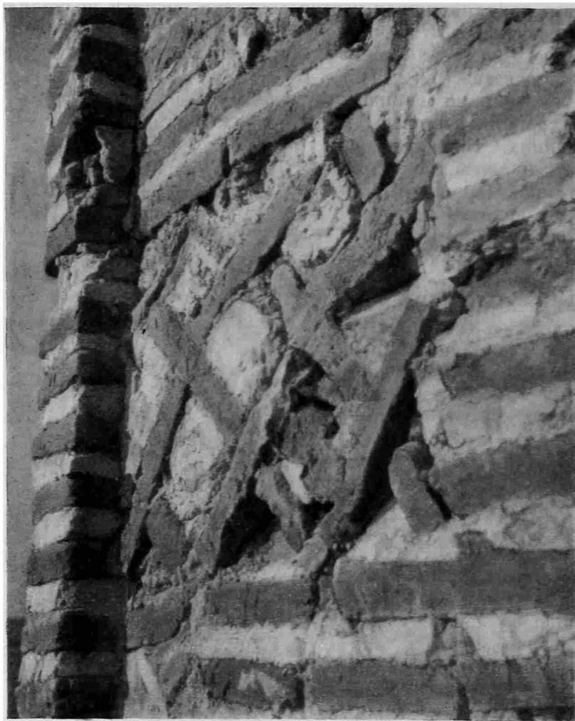
Рис. 8. Деталь восточного фасада — кирпичный узор и полуколонка.
