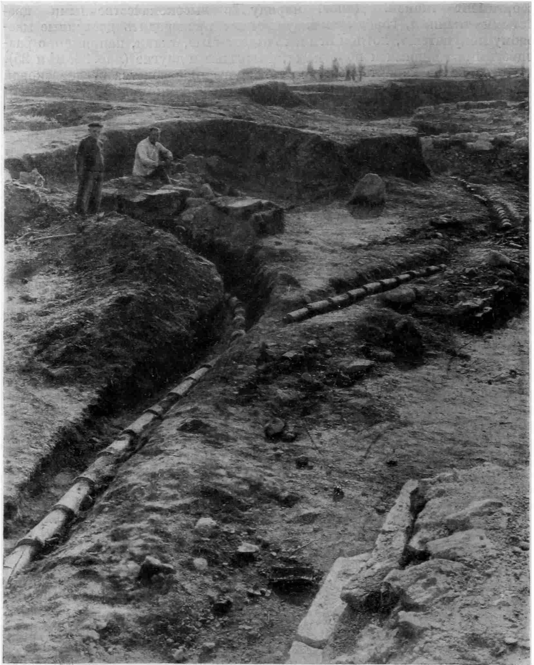
Рис. 20. Линия водопровода из гончарных труб на территории города Двин.
