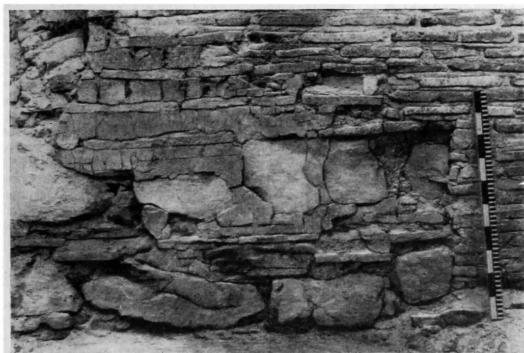
Рис. 10. Часть южной стены собора (слева— кладка XI в., справа —кладка XIII в.).
