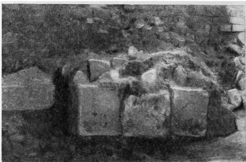
Рис. 6. Блок кладки западной стены (деталь).
