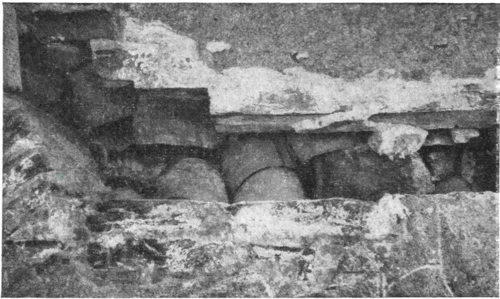
Рис. 10. Заполнение внутреннего пространства стены барабана гончарными сосудами
