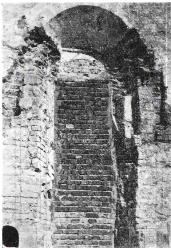
Рис. 10. Следы наличника окна южной стены
