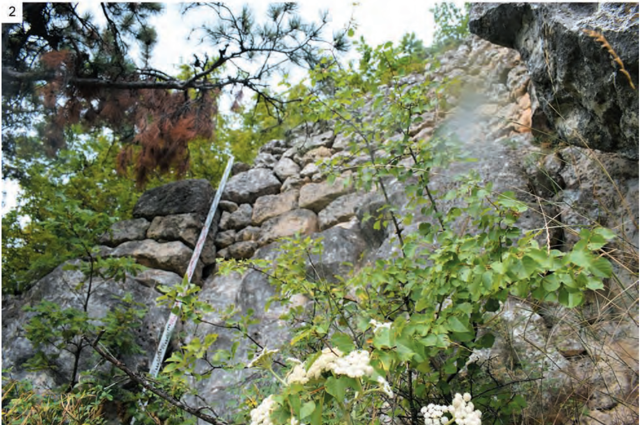
Рис. 12. Укрепление А.ХІІІ. 1 – вид с юго-запада; 2 – контрфорс
