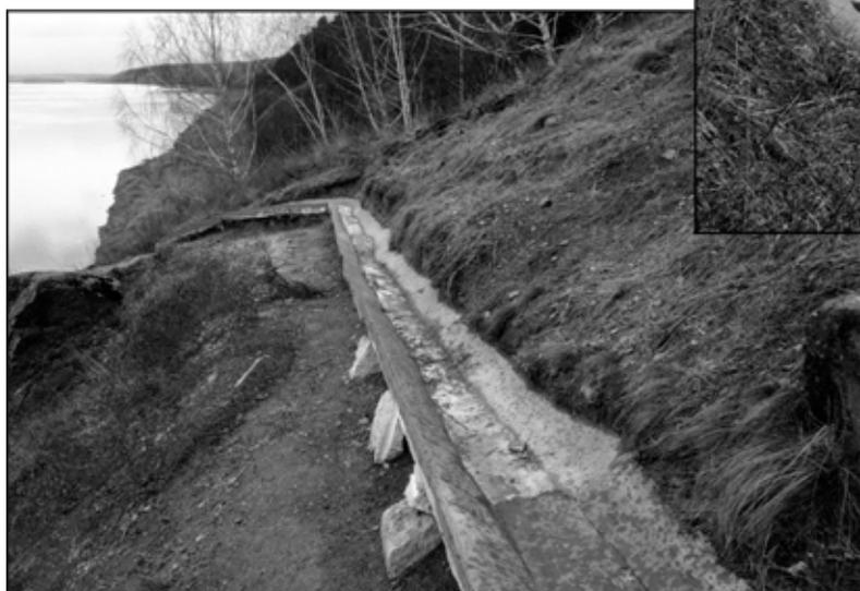
**Новое водоотводящее устройство – открытый лоток, устроенный на основе сохранённой бетонной отмостки.**
