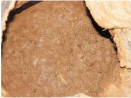
1 — Вспучивание обмазки пода печи в процессе просыхания. Поэтому в процессе сушки ее было необходимо уплотнять
