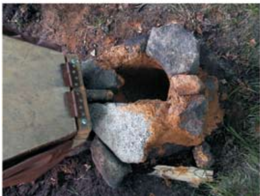
5 — Печь в процессе строительства. Гранитные блоки уложены на глиняный раствор
