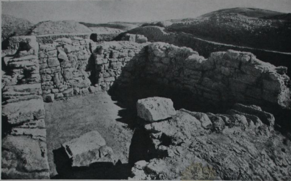
Рис. 2. Вид на руины мавзолея с запада
