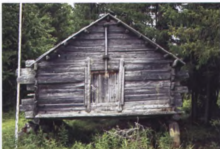
Рис. 31. Село Питляр Шурышкарского р-на ЯНАО. Хозяйственный лабаз Озеловых. Западный фасад. Фото М. Н. Труняевой. 2004 г.
