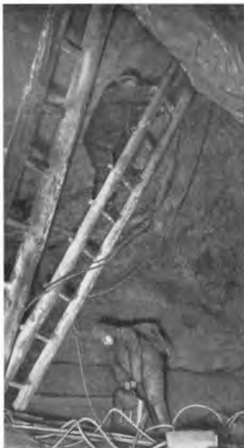
Рис. 10. Путь по одной из лестниц, ведущих в верхний этаж пещеры. Прокладка электрического кабеля
