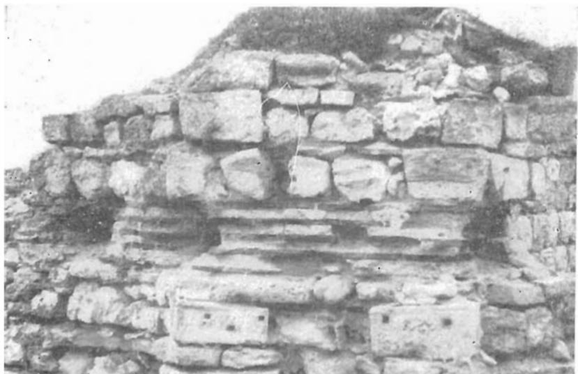
*Фото 44.* Угол крещальни возле Уваровской базилики. В каменной кладке виден пояс плинфы (тонких керамических плит), прослойкой известковым раствором. Назначение пояса — сделать сооружение более сейсмостойким. Подвоя высота угла около 3 м.
