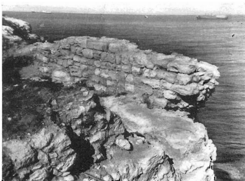
*Фото 18.* Восточная оборонительная стена, разрушенная вследствие абразии берега; высота кладки около 2 м, толщина стен 2,2—2,3 м. Район базилики Крузе (см. рис. 8,28).
