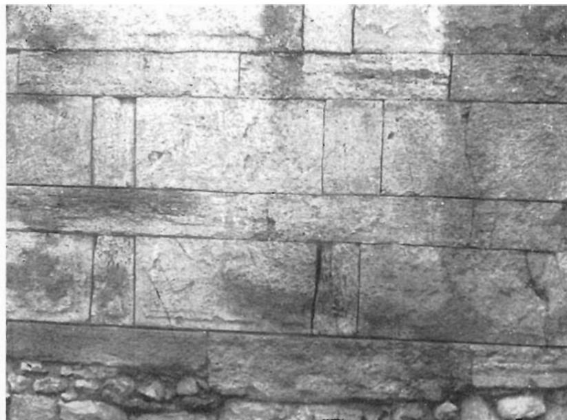
*Фото 13.* Тыльный панцирь главной оборонительной стены возле казармы (см. рис. 23, 24). Кордонная кладка панциря опирается на плитовый цоколь и бутовый фундамент (внизу). Плиты уложены без раствора. Высота каждого ряда плит 30 и 60 см.
