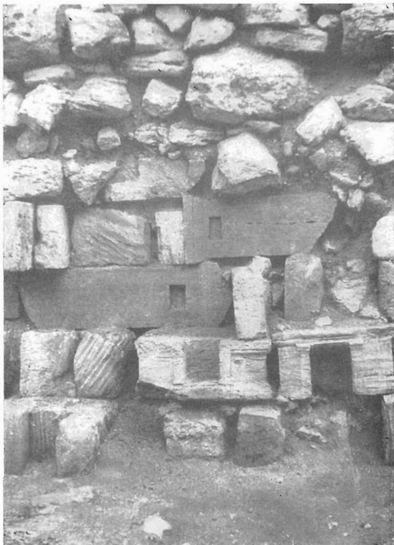
*Фото 14.* Протейхизма против 16-й куртины. Внизу — остатки античной протейхизмы, сложенной из надгробий, вверху — бутовая кладка (на известковом растворе) фундамента средневековой протейхизмы. Длина надгробья в третьем ряду снизу 1,3—1,4 м.
