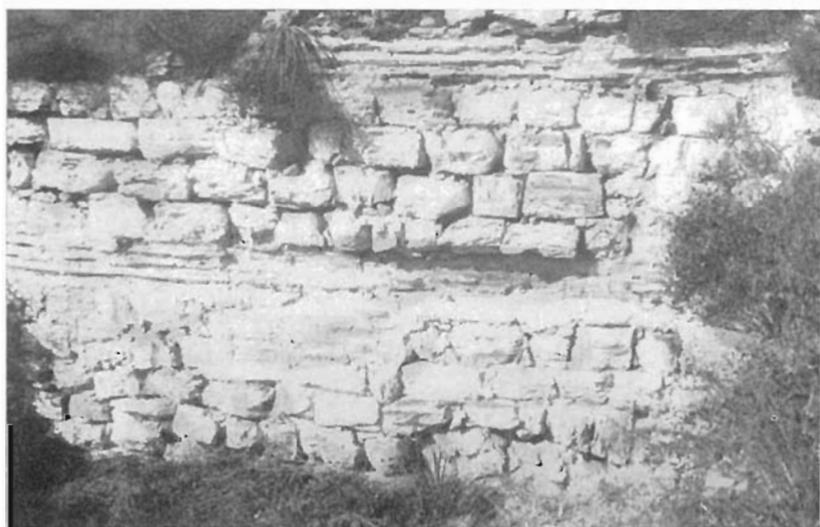
*Фото 45.* Стена одного из средневековых зданий в восточной части Херсонеса, с двумя поясами плинфы. Высота около 4 м.
