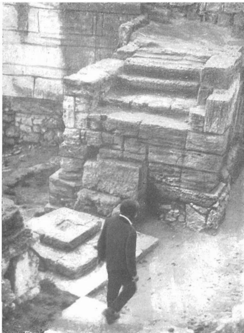
Фото 20. Внизу — постамент статуи или декрета (античное время), слева — угол казармы, справа — внутренний шпон античных ворот (в 16-й куртинке), позднее переоборудованный в лестницу. На дальнем плане видна кордонная кладка тыльного панциря оборонительной стены и ее бутовый фундамент.
