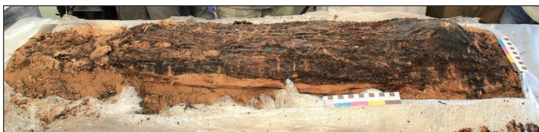
Рис. 5. Верхнее перекрытие деревянной конструкции, состоящее из дуба
